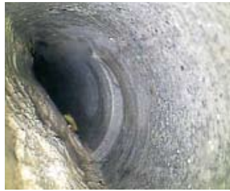
Mittels Kleinst-TV-Kamera rasch lokalisiert: Kalk verengt das Rohr.
