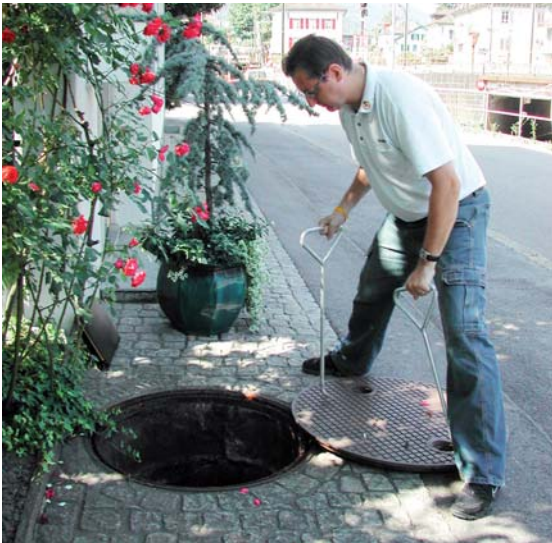
Vorbeugen: Mit der RohrMax-Vorsorge-Rohrkontrolle
